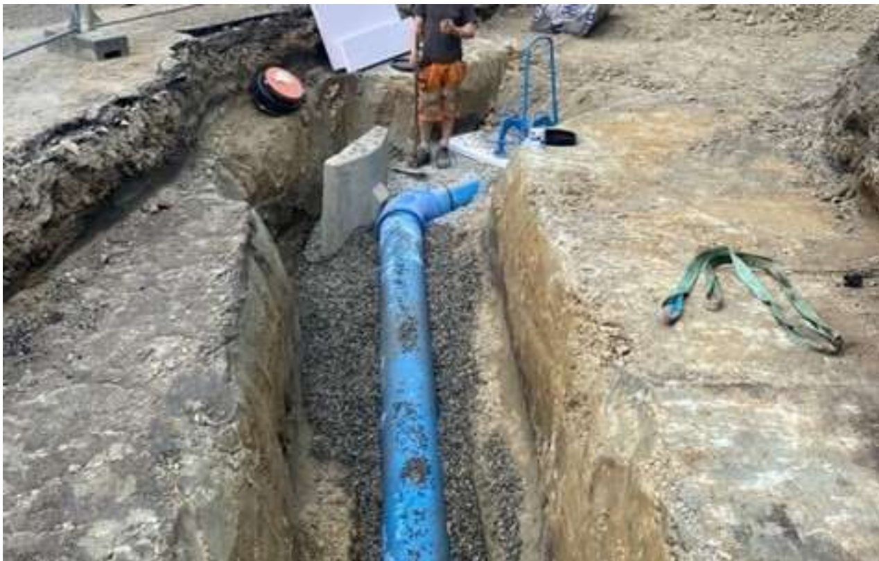
Figur 10: Forankringskloss på bend mellom kummer.
