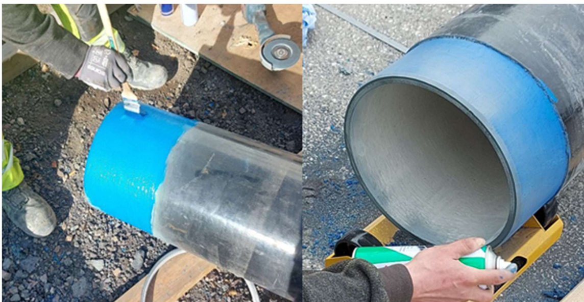
Figur 14: Forberedelse til skjøting.
