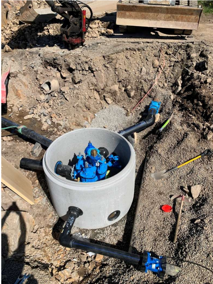
Figur 4: Oversiktsbilde som viser rørgjennomføringer.
