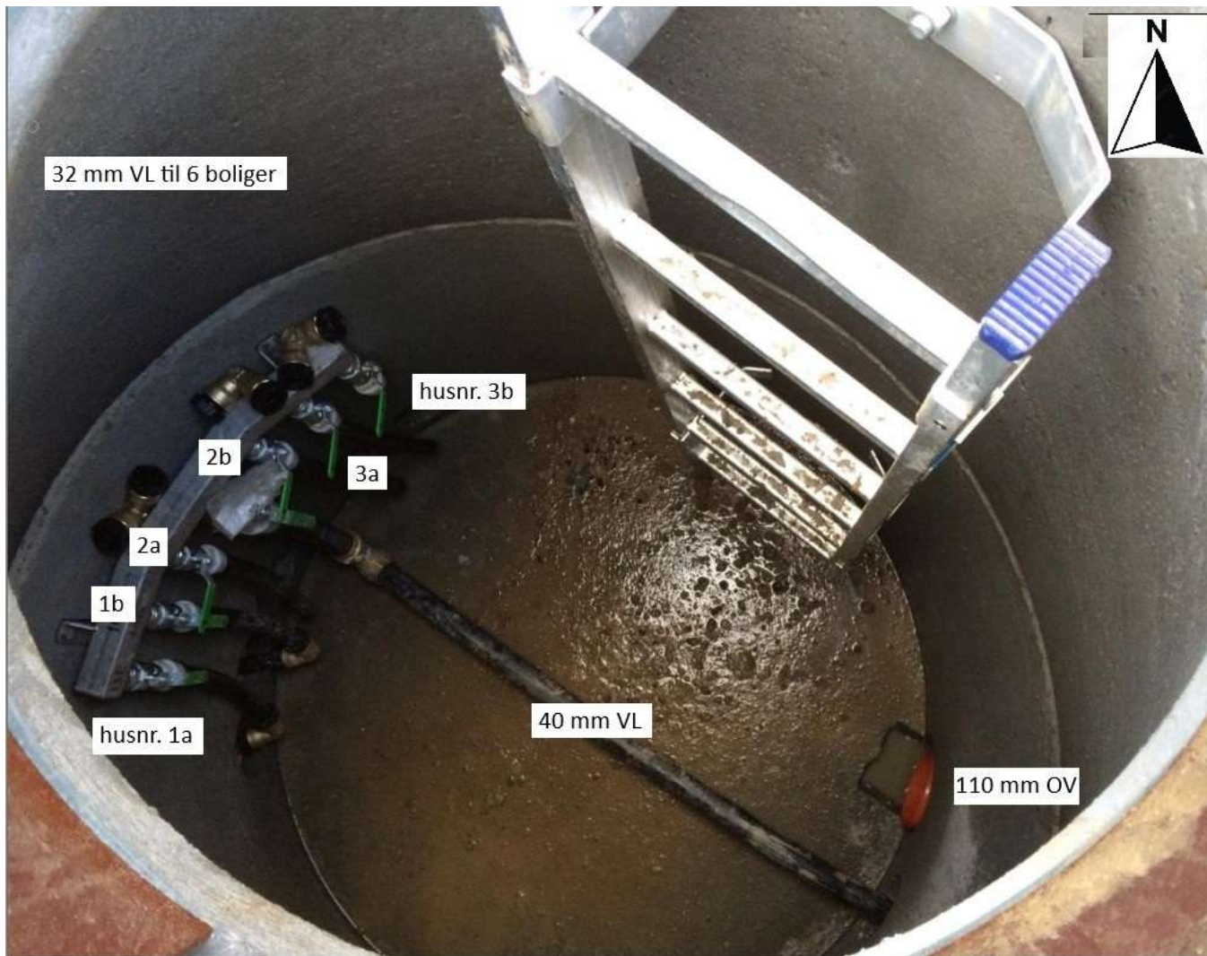
Figur 6: Manifold med annotasjoner (husnummer på stikkledninger, m.m.)
