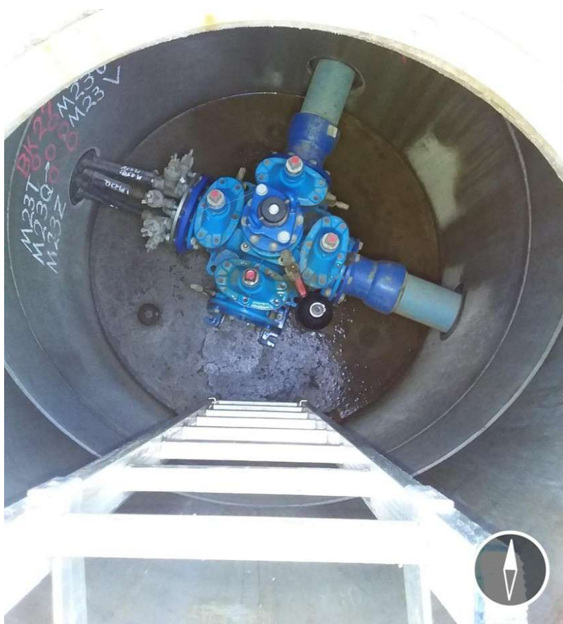
Figur 7: Samleflens for flere stikkledninger. Adresser for hver stoppekran er markert på kumveggen.
