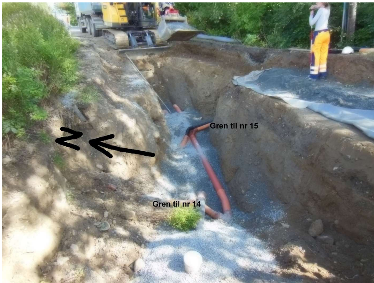
Figur 13: Påkoblingspunkter (grenrør).
