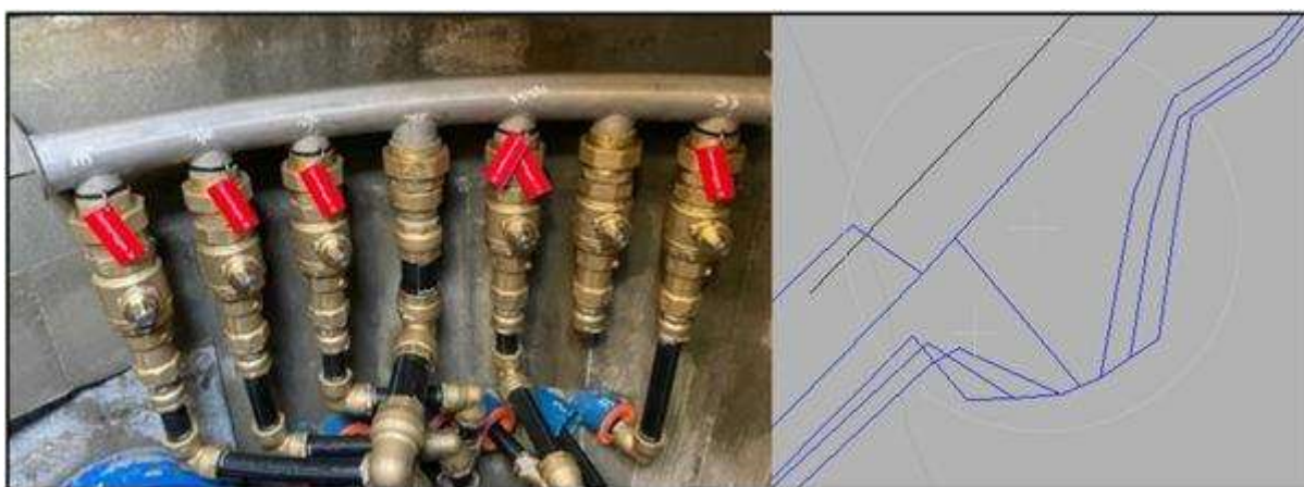
Figur 8. Innmåling av stikkledninger gjennom manifold.
