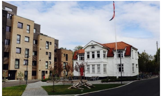
Figur 55: Villa Briskeskjær i Ormerudveien, Kolbotn. Her ble et gammelt hus gjenoppbygget og omringet av ny blokkbebyggelse. Villaen brukes i dag som felleslokale.
