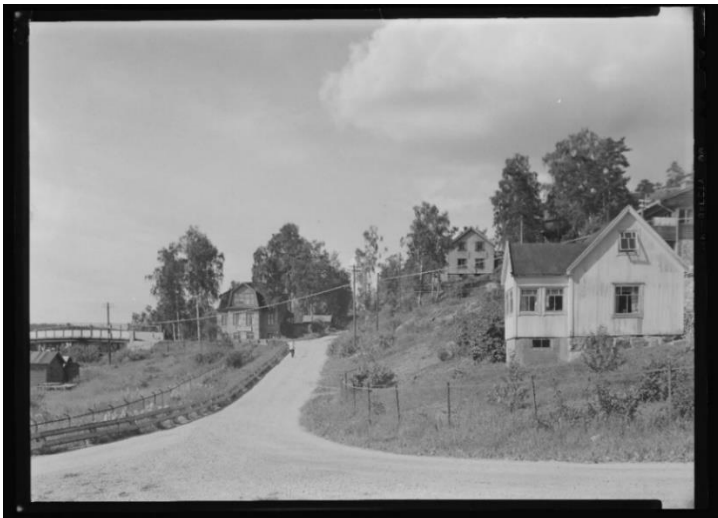
Figur 7: Bru over jernbanen sett fra Sætreskogveien på 1960-tallet. Foto: Nasjonalbiblioteket.
