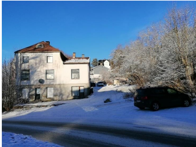
Figur 53: Sætreskogveien 3 med bevaringsverdig bebyggelse. Her var det tidligere butikk i 1.etasje, som områdereguleringen igjen åpner for.
