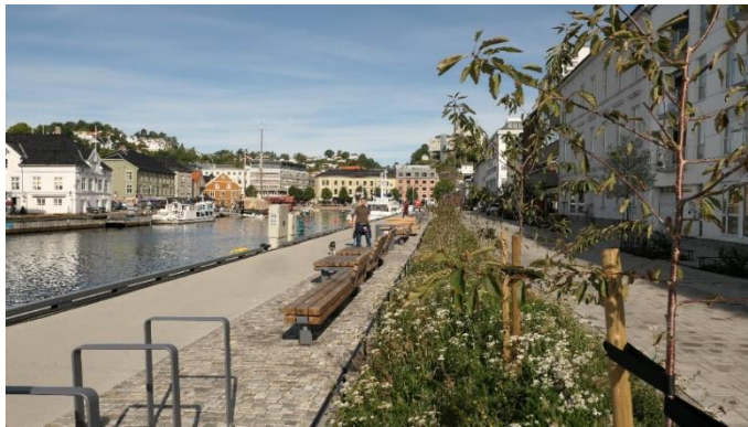
Regnvann fra fortau og gate er ført til grønne rabatter (Langbryggen og Langkaia i Arendal)
