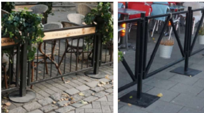
Eksempel på stødig fot til pullert som ikke trenger nedstøping. Foto: Trondheim kommune
