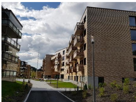
Figur 16. Kolbotn omsorgsboliger var den første kommunale fossilfrie byggeplassen i Nordre Follo kommune.
