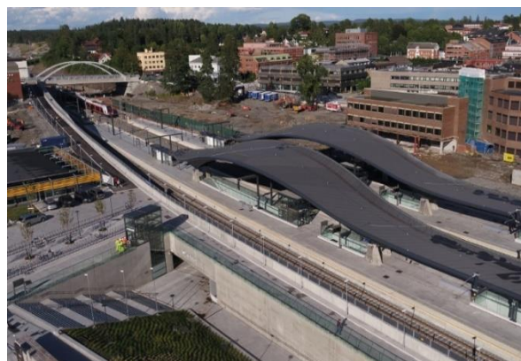
Figur 9. Vestsiden av ny Ski stasjon ble åpnet for trafikk august 2020. (Foto: Bane NOR)
